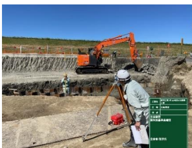
遊水池整備工事 現場監理業務
