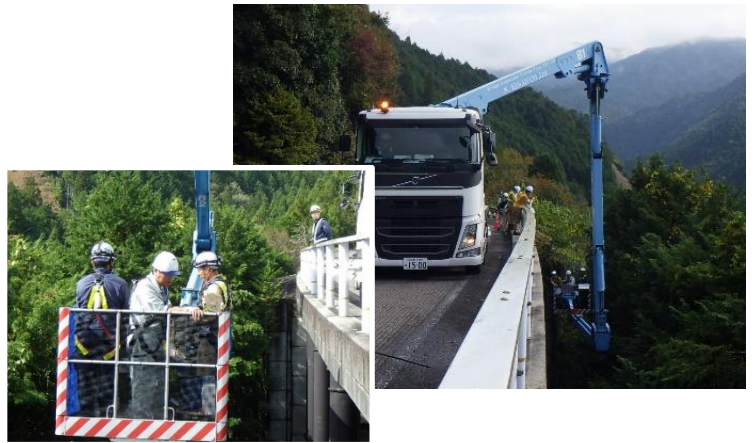
大型点検車（AB-1500）よる点検状況
