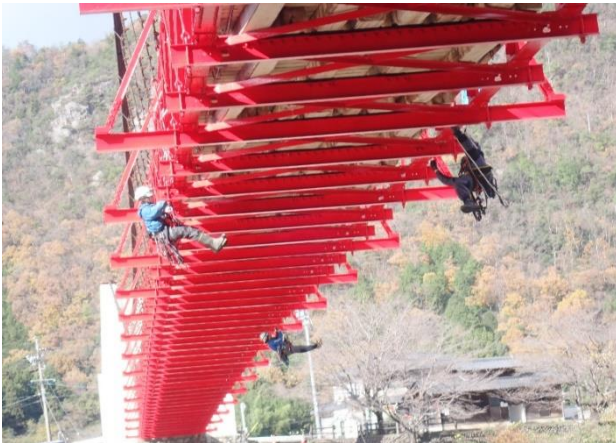
国重要文化財美濃橋の高所特殊技術による点検状況
