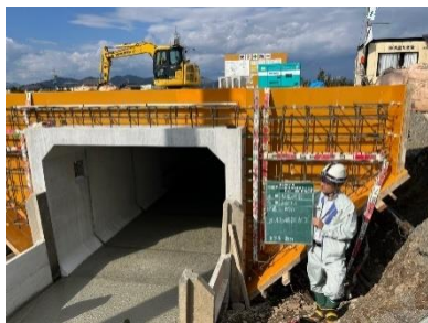
道路改良工事 現場監理業務
