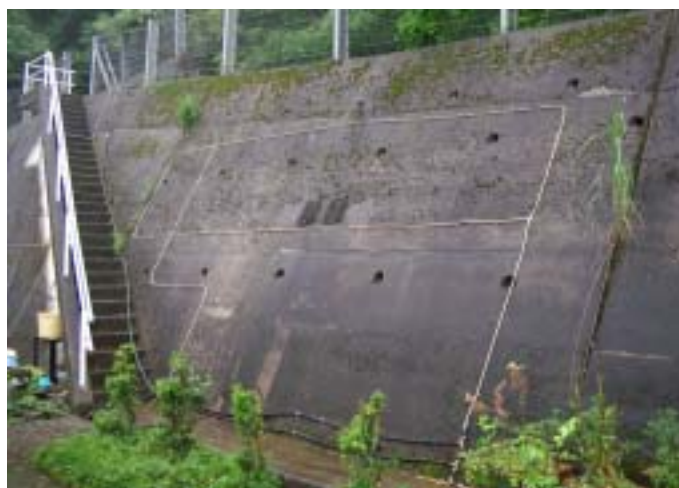
ミスト(霧状)散水配管設備設置状況
