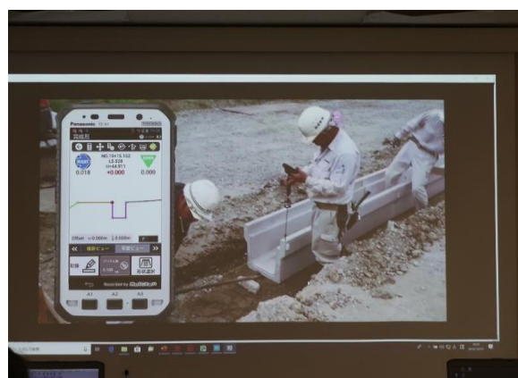
タブレット端末を用いて構造物の位置出し、丁張、敷高の検測等を行う等、生産性向上のための測量機器の活用方法について動画により学びました。
