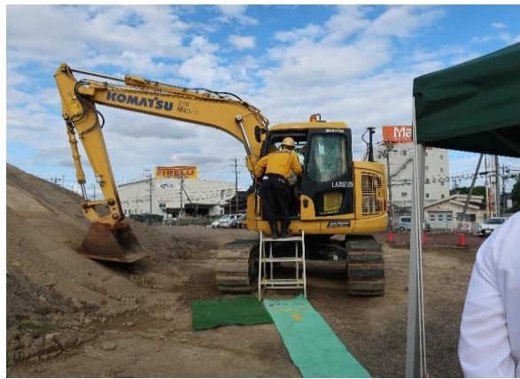
“建設ICT実機操作体験” 施工ヤードにて、ICT油圧ショベルの操作体験を行います。
