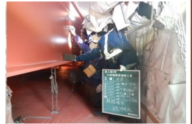
橋梁補修工事の現場管理
