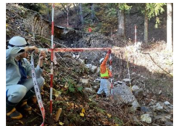
災害復旧現場
