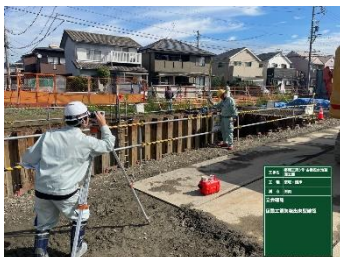
遊水地工事積算・現場監理業務
