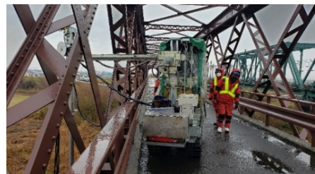
橋梁点検の様子
