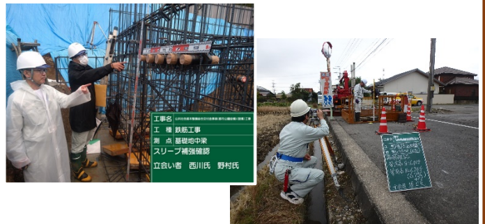
工事管理業務の様子
