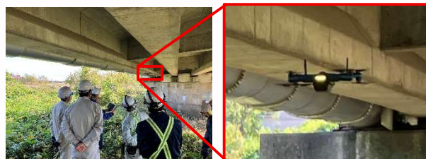
ドローンによる橋梁点検の様子
