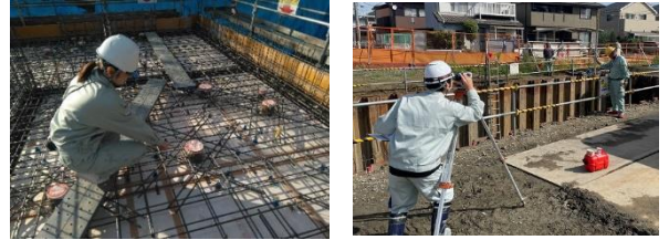
工事管理業務の様子
