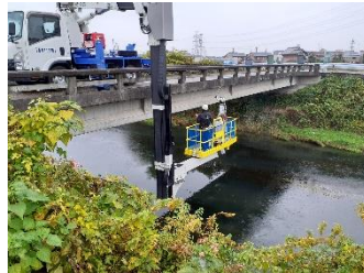
橋梁点検の様子
