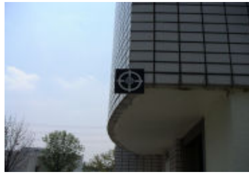
図3-18 ターゲットの設置状況
