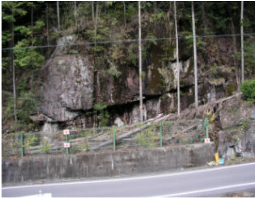
図3-26 岩盤斜面（岐阜県加茂郡白川町）
