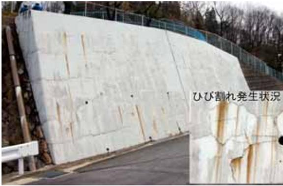
(a) 施工前のひび割れ発生状況
