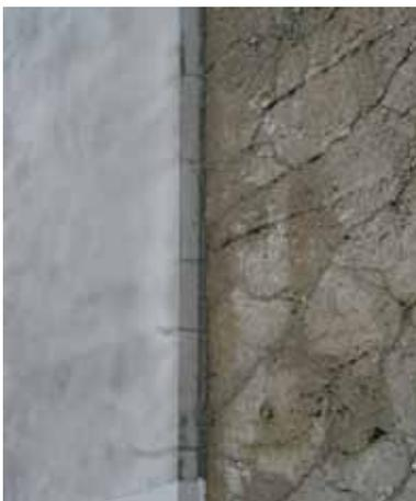
・ブロック No.9 : 側面に 30cm 間隔のひび割れ発生
