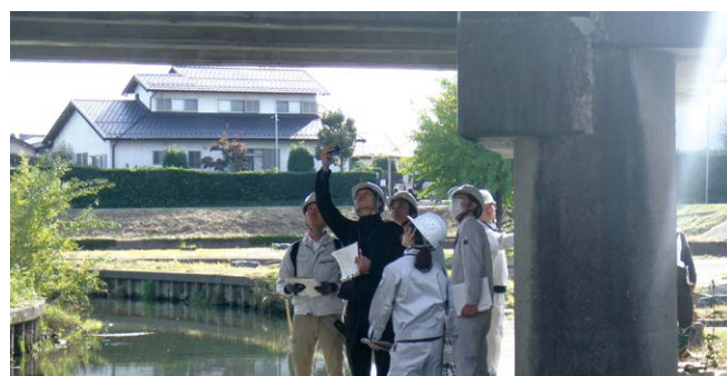
【建設関係行政職員研修】橋梁点検研修
