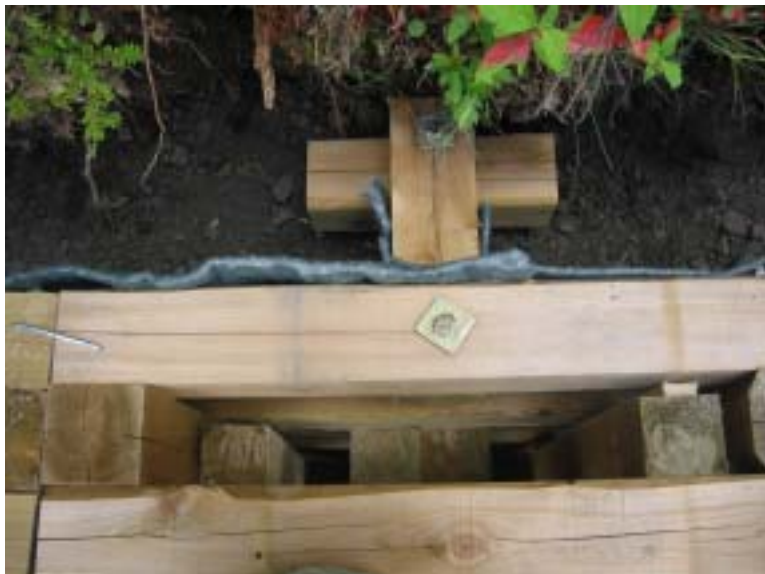
連結木固定状況（添え木差し込み）
