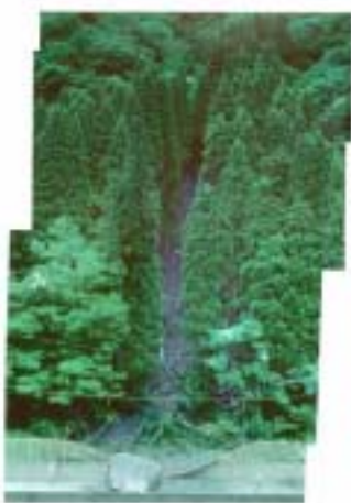
落石により法面が500mにわたり崩壊
