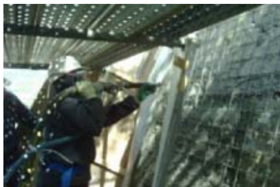
写真-1 吹付け施工の様子
