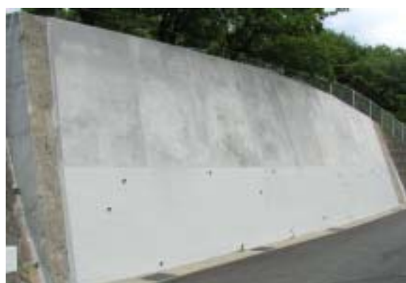
写真-2 施工後の様子(壁の両端は未補修)
