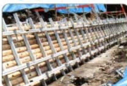
4 鋼管バタ角にて補強
