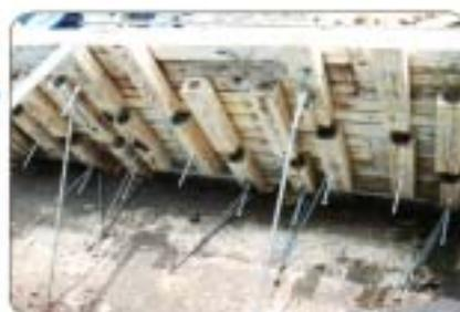
3 平型枠をセット・鉄筋で補強
