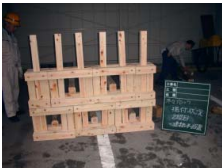
(ブロック組み立て状況)
