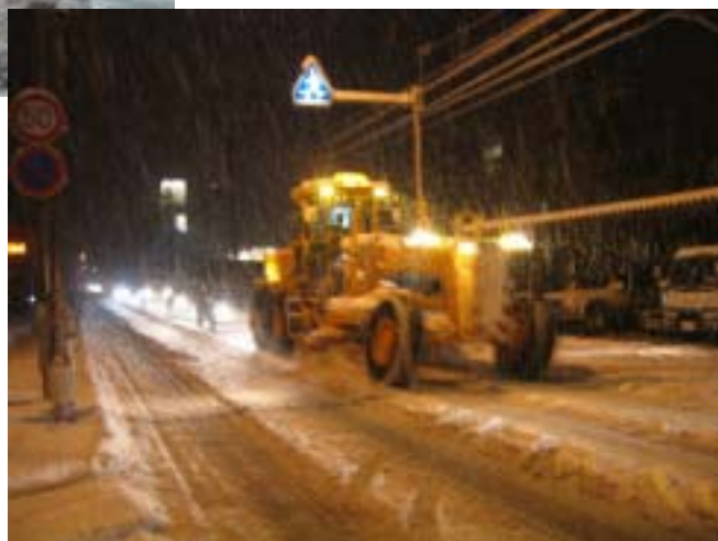
夜間除雪作業
