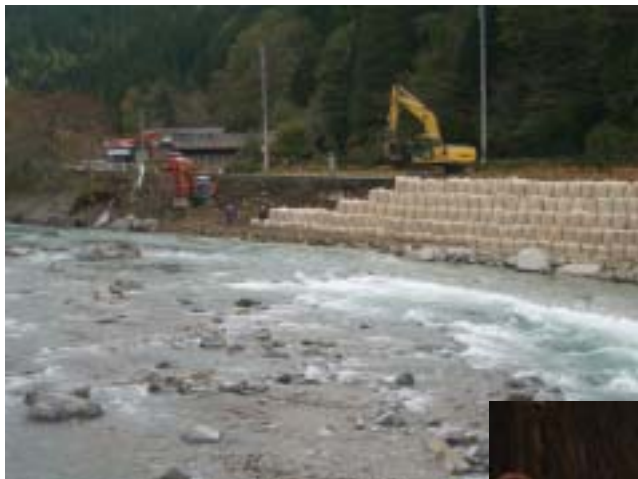
災害応急復旧工事
